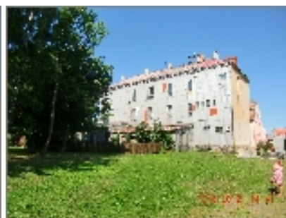
obr. 3-celkový pohled na dvorní fasádu
