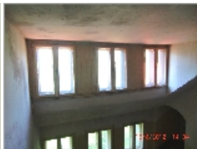
obr. 24-okna na schodišti bez přístupu k nim
