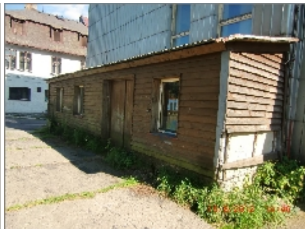
obr. 69-panelová cesta k vratům budov č.2 a č.3
