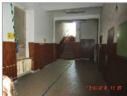
obr. 14-chodba v 1.NP. má keram. dlažbu
