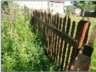
obr. 65-ocel. sloupky jsou zkorodované
