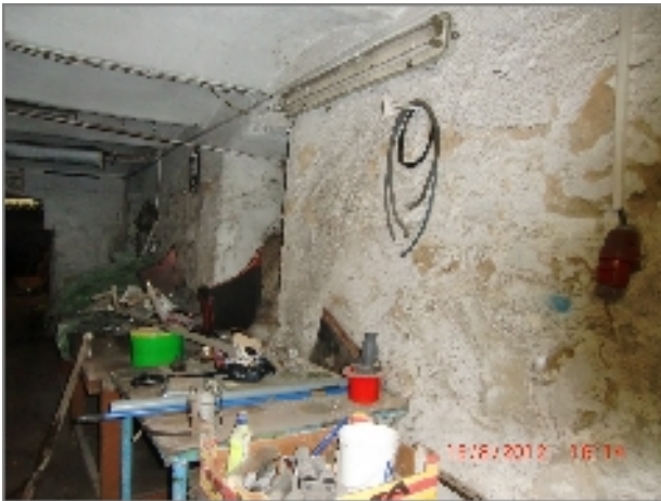
obr. 39-v 1.PP. vzlíná zemní vlhkost až ke stropu
