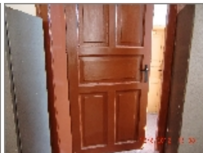
obr. 18 -ve 2.NP. jsou původní dveře
