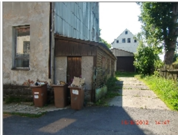
obr. 71-napojení na veřejnou ulici Vítězná, vzadu budova č.3
