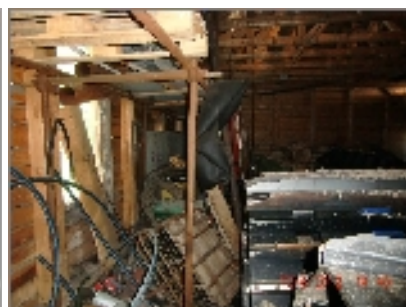
obr. 58-obvodový plášť zevnitř
