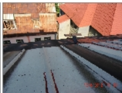
obr. 9-utržené sněhové záchyty
