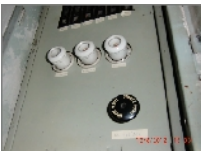
obr. 28-porcelánové jističe
