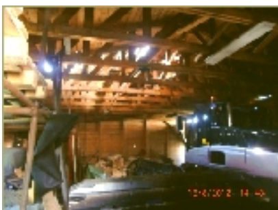
obr. 56-celkový pohled na interiér
