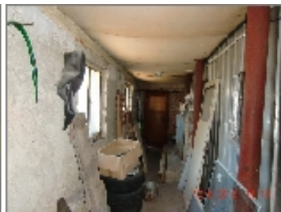
obr.12-zádvěří, vstup z ulice do 1.PP.
