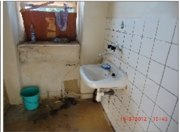
obr. 40-obklad ve 3.NP. v soc. zázemí, viz v parapetu trhlínu
