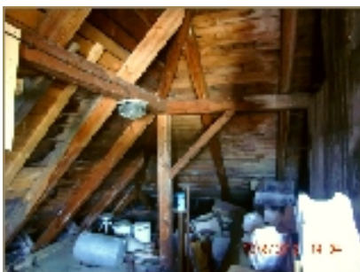
obr. 13-dřev. krov valbové střechy
