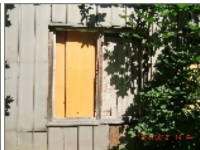
obr. 52-rozbitá skla v oknech
