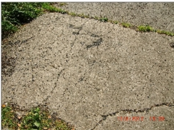
obr. 68-detail stavu některých panelů
