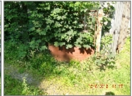
obr. 67-plechová vrata s pletivem jsou zkorodovaná
