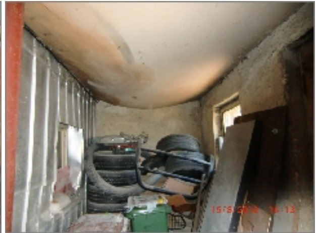
obr. 38- v zádveři zatéká do střechy
