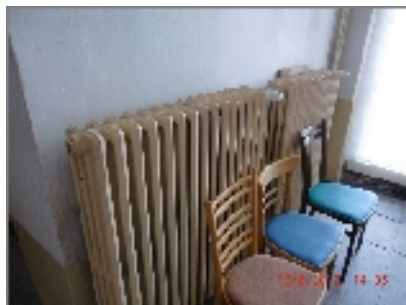
obr.26 -litinové radiátory z r.1978
